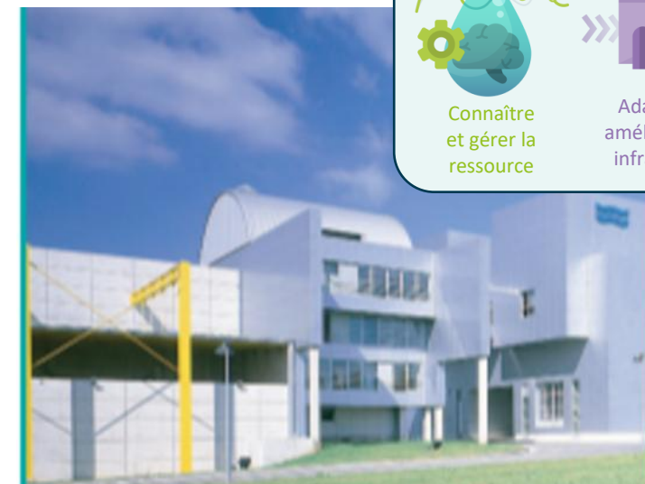
Station de potabilisation de Gaurain-Ramecroix
